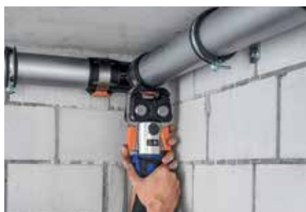
↑ Sertissage même dans les endroits exigus ou difficiles d'accès avec les gros diamètres.
